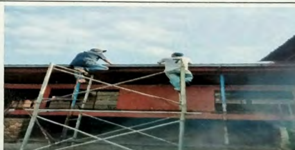
Foto 6: Vista de proceso de desmontaje de estructura de madera en mal estado y de lamina de asbesto a ser retirada.
