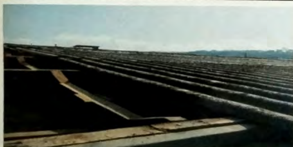
Foto 5: Vista de estructrua de madera y lamina de asbesto a ser retirado.
