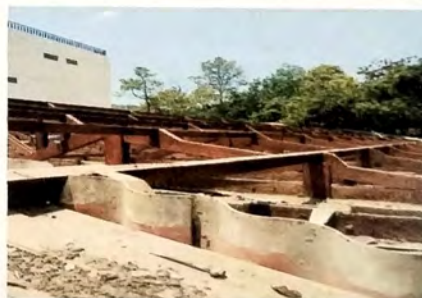
Foto 4: Visita de estructura de madera a ser desmontada.
